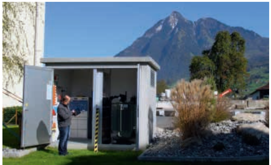
Bild 2 Inspektion einer Transformatorenstation mit Tablet.
